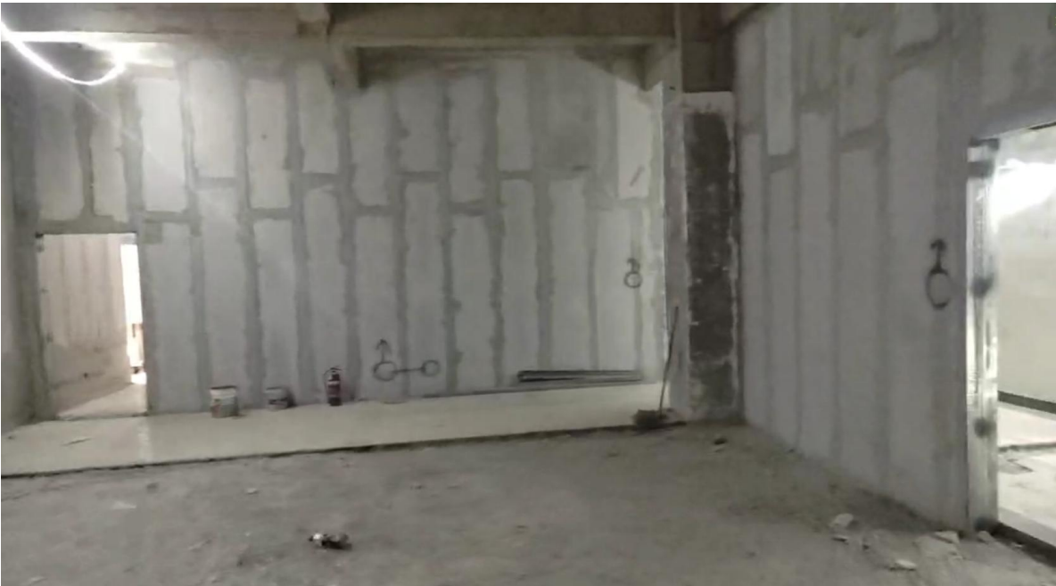
图8-1 本项目介入诊疗室1现状图
